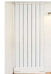
輻射式冷暖房パネル (各居室+洗面室に設置)
